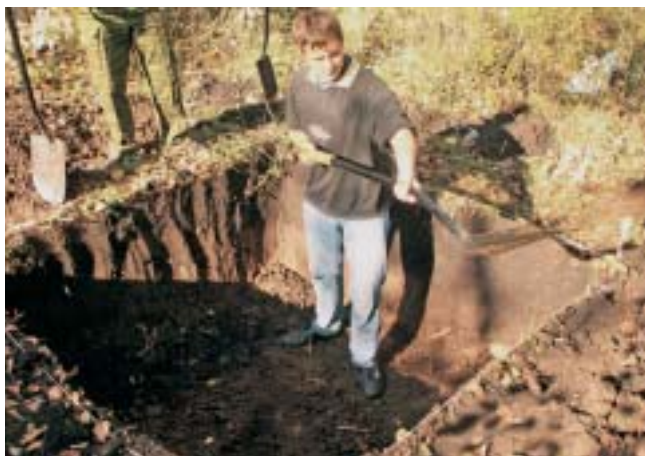
Процесс шурфовки
