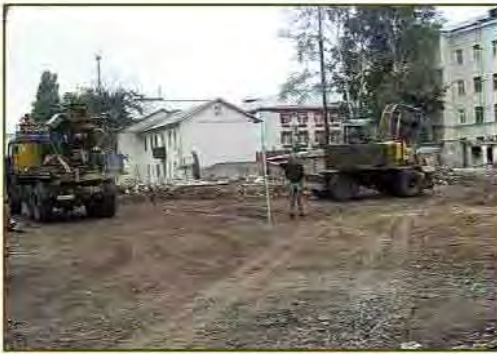
Участок проведения работ
