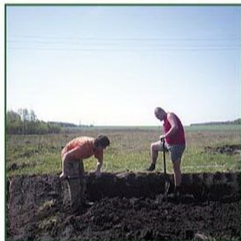
Грязинский район. Зачистка стенок котлована
