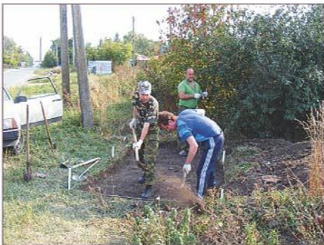
Процесс работ. г. Лебедянь
