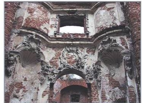
Фрагменты лепного декора, сохранившиеся на стенах.
